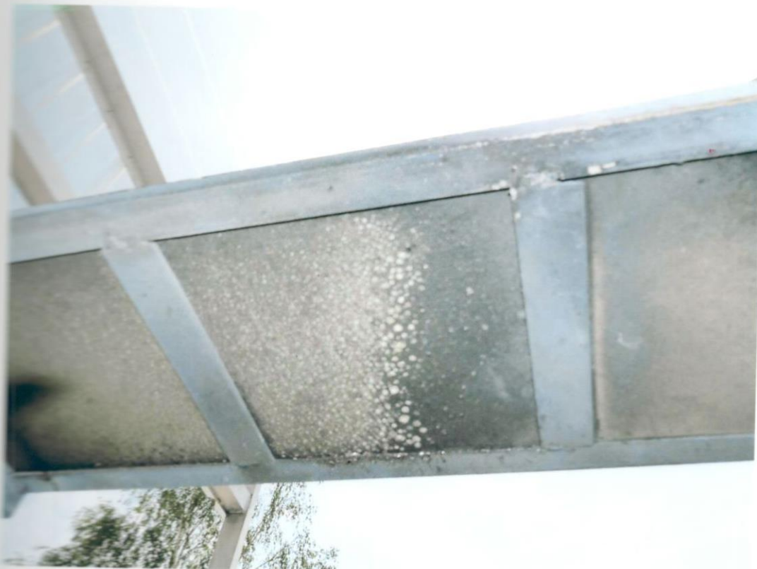
Obr. 5 Zkušební vzorek po zkoušce obloukovým zkratem na zkušebním kabelu vn - detailní pohled na kabelovou lávku nad poruchou
